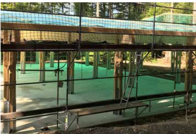
Unter anderem um verletzte Tiere zu versorgen, wird eine neue Anlage im Tier-Freigelände bei Neuschönau gebaut. Foto: Annette Nigl
