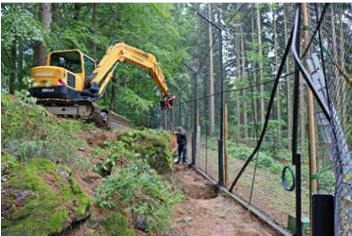
Laufend fanden in beiden Tier-Freigeländen Reparaturarbeiten statt, so wie hier im Neuschönauer Luchsgehege. Foto: Gregor Wolf
