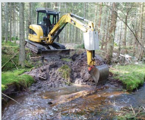
Durch den Rückbau von B'schlachthölzern steigen Strukturvielfalt und Dynamik im Gewässer.
