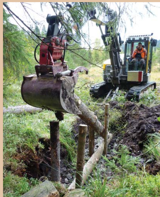
Bau eines Rundholzdamms
