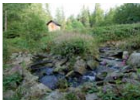
Die Barrierewirkung von Wehren an Kleinkraftwerken oder Triftklausen, wie hier an der Knotenbachklause, wird durch Umgehungsgerinne entschärft (Foto: Hans Kiener)
